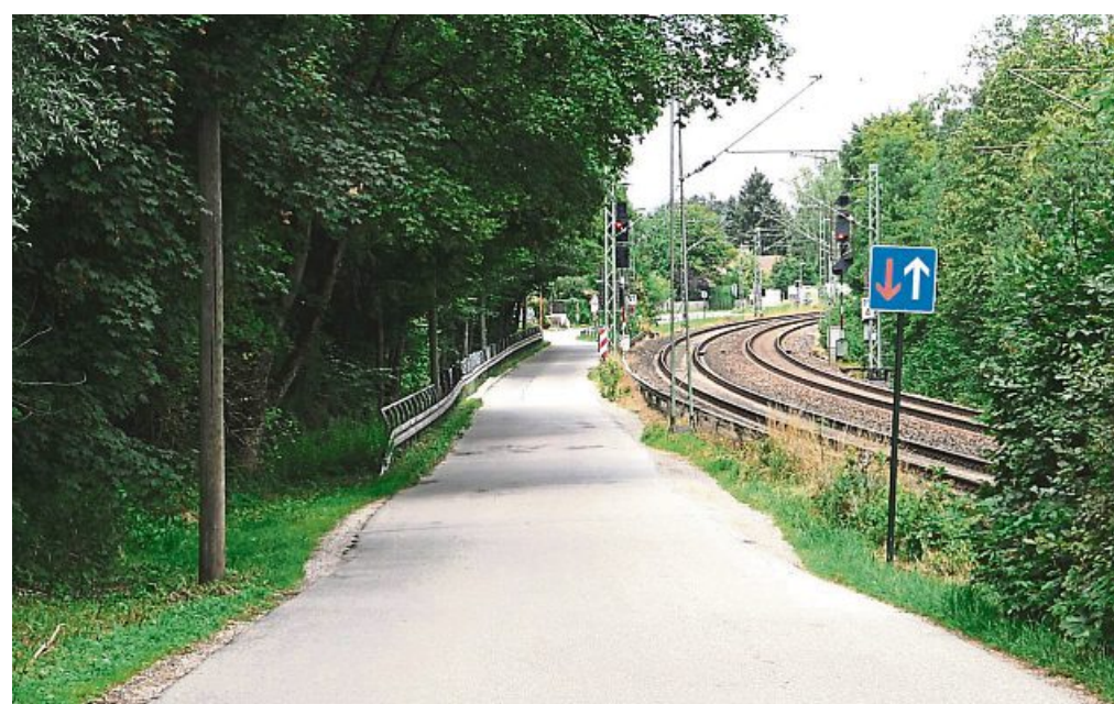
Die Sauerlacher Straße wird komplett saniert wird samt der Brücke über das Gleisental. Das kostet die Gemeinde in diesem Jahr rund vier Millionen Euro.
