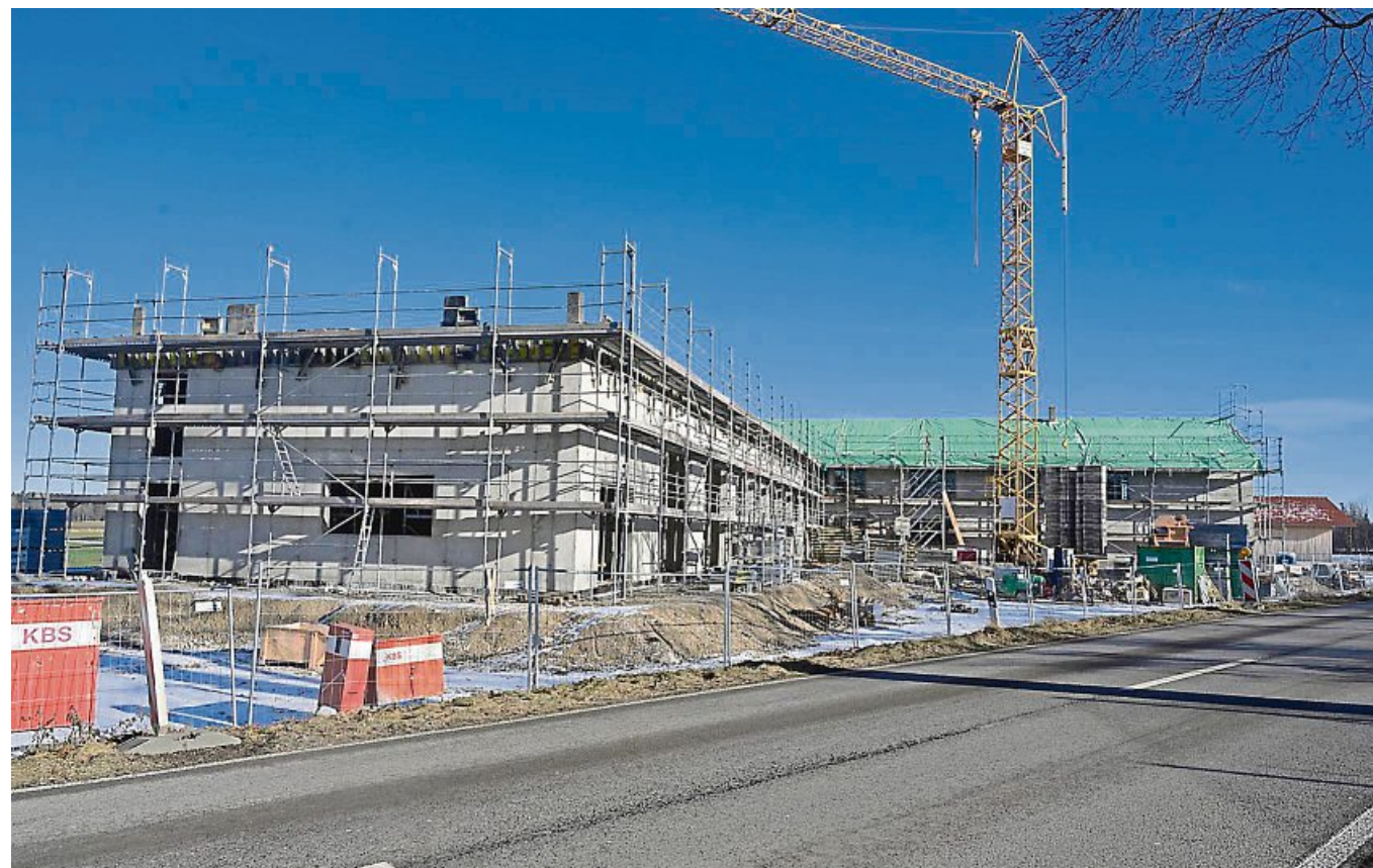
Voll im Zeitplan liegt der Bau des Feuerwehrhauses Siegertsbrunn, der wohl Ende des Jahres abgeschlossen ist. FOTO: SW
