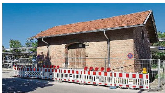
Sollen wieder genutzt werden: das Bahnhofsgebäude und seine kleinen Nebengebäude.
