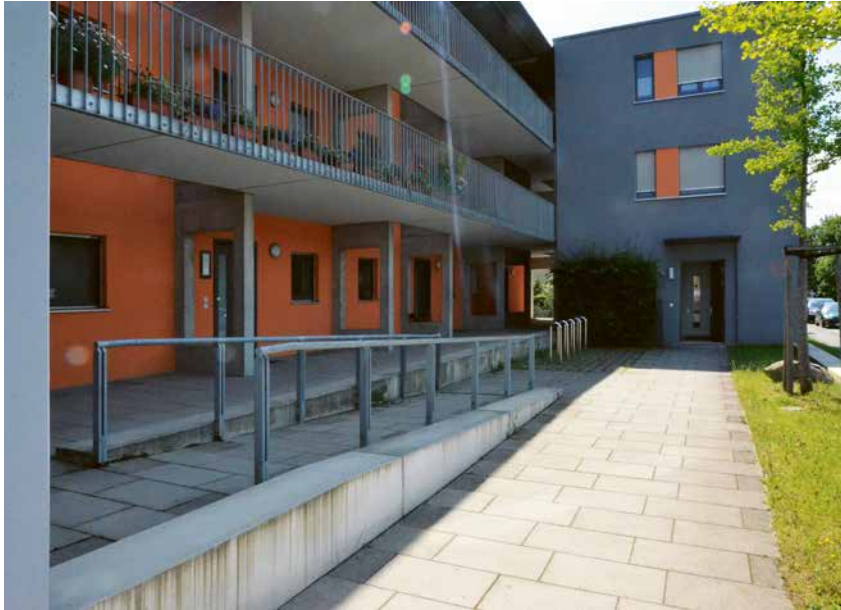
Ein vorgestelltes Laubengangsystem erschließt sowohl den Bestand als auch die an den Laubengang anschließenden Wohnungen der Ergänzungsbauten. ♣ Nürnberg, Dresdener Straße
