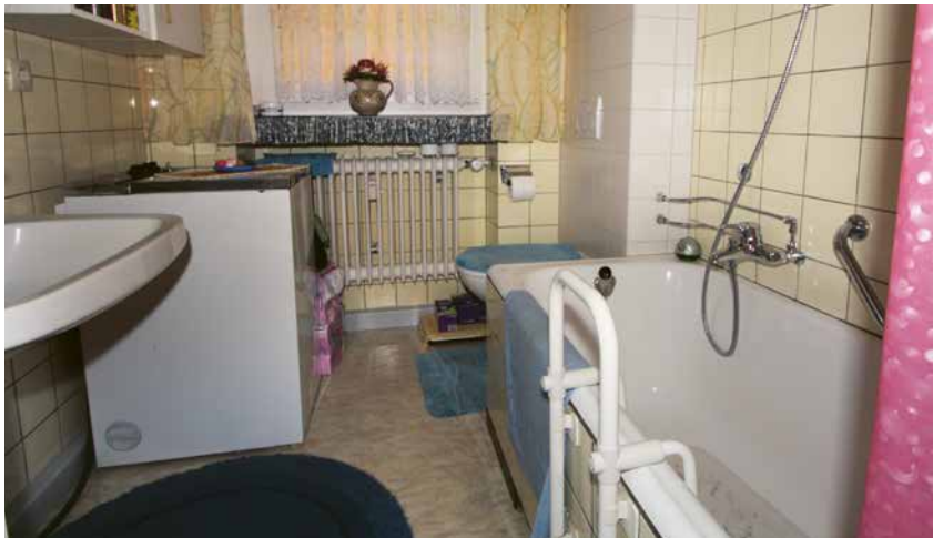
Typisches Bestandsbad. Die Unterbringung der Waschmaschine macht eine komfortable Nutzung des Bades unmöglich.
