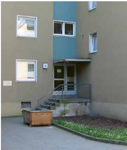
Bestand Eine halbe Geschossebene muss überwunden werden.
