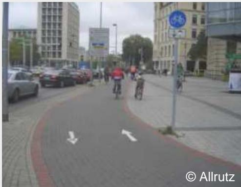
**Zweirichtungsrادweg** mit straßenbegleitender Führung Breite  $\geq 4\text{m}$
