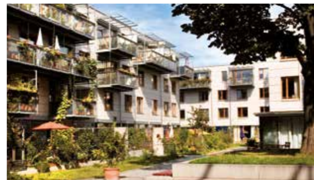
Abb. 10: Wohnensemble der Baugenossenschaft Wagnis in München (Quelle: Wohnbaugenossenschaft Wagnis e.G.)
