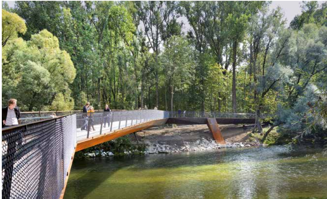
Abb. 33: Der neue Isarsteg in Freising – wichtiger Lückenschluss im städtischen Radwegenetz und Verbesserung der Anbindung Lerchenfelds an die Reststadt (Quelle: Stadt Freising)
