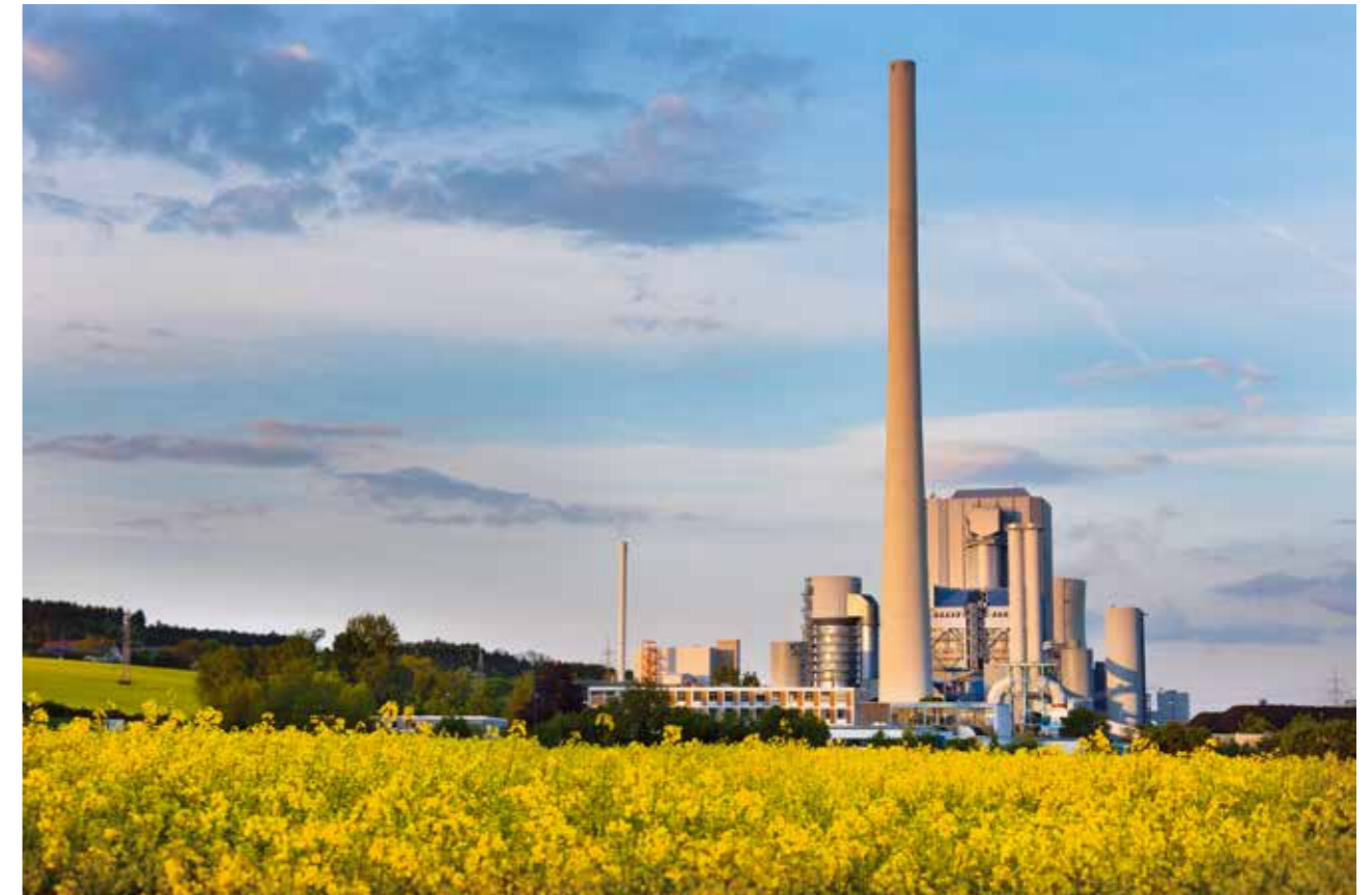
Abb. 44: Das Heizkraftwerk Zolling wird in Kraft-Wärme-Kopplung und teils mit nachwachsender Biomasse betrieben. Die erzeugte Energie wird in das städtische Fernwärmenetz eingespeist. (Quelle: GDF SUEZ Energie Deutschland AG)
