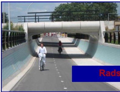
Zweirichtungsradweg – separat geführt
